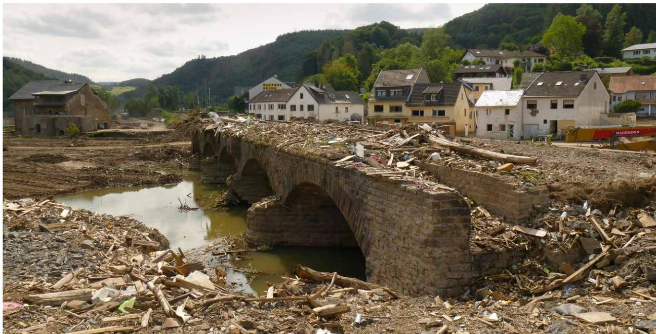
Ahr bei Kreuzberg mit gut sichtbaren Verkläuerungen durch Treibgut an Brücken
